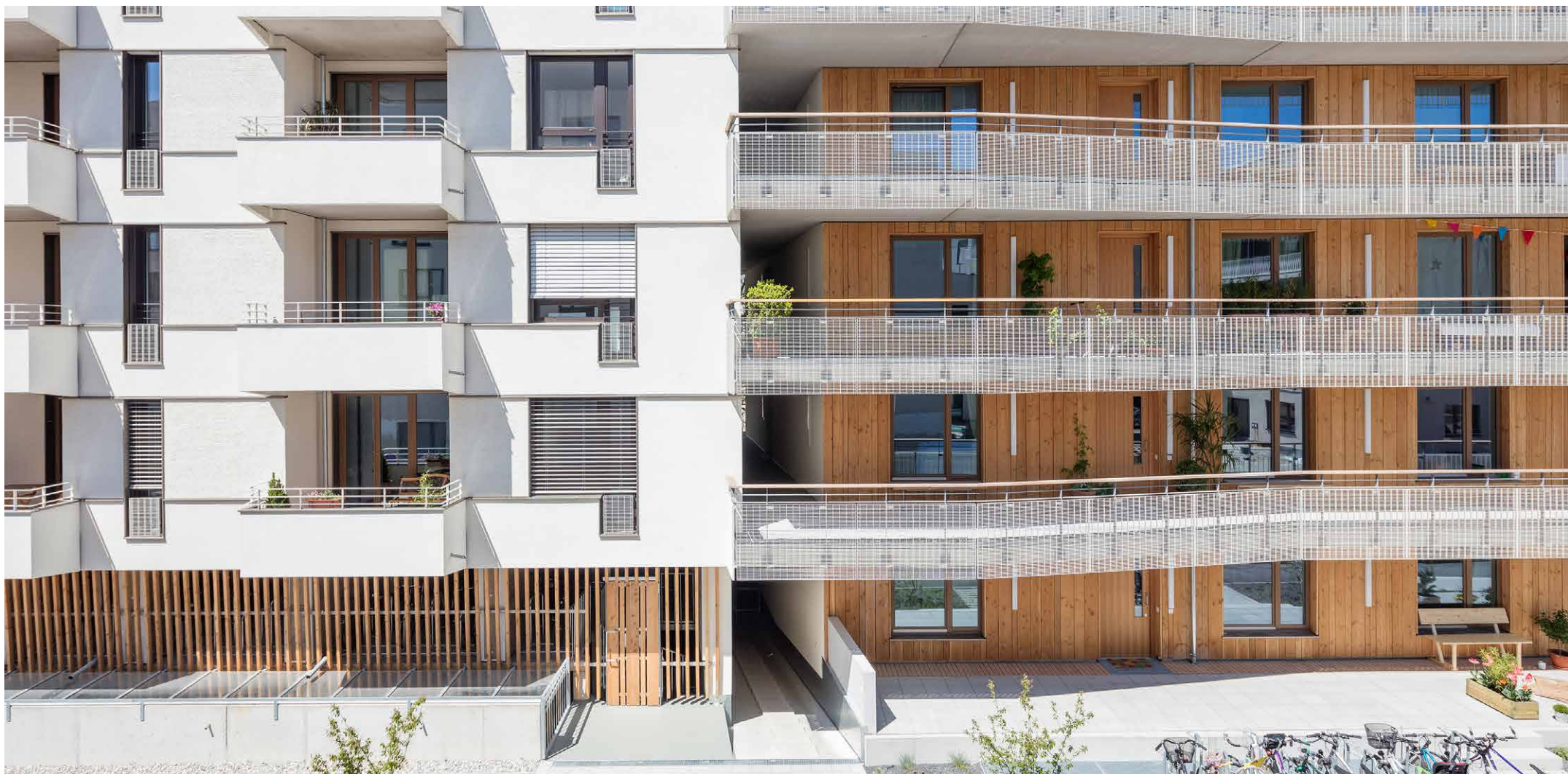
Ostfassade | Übergang Holz/Putz
